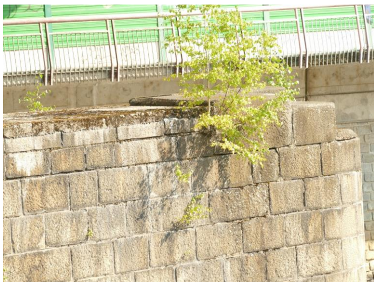
Pilíř P 01: dřík – vypadané spárování, nárůst vegetace
