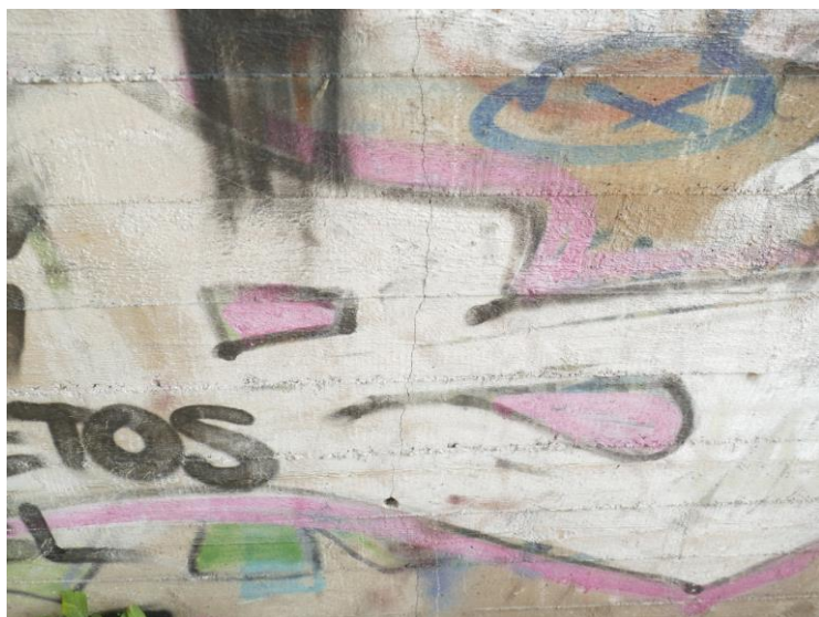
Opěra O 02: dřík – svislá trhlina
